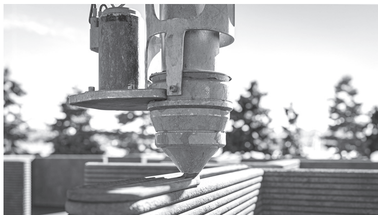
Figura 6: La boquilla del brazo del robot de impresión en 3D mientras construye la pared de una casa
